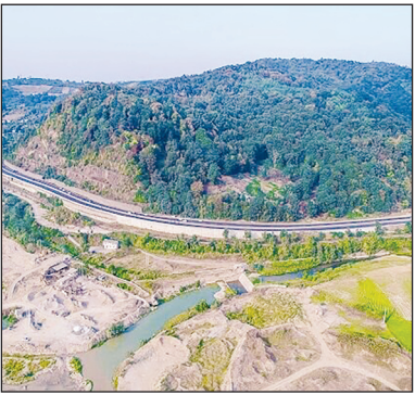
اجرا داشته که این عملیات شامل اجرای روکش آسفالت، خط کشی، نصب جداکننده ها و همچنین نصب انواع تابلوهای هشداردهنده انظامی و اطلاعاتی،
