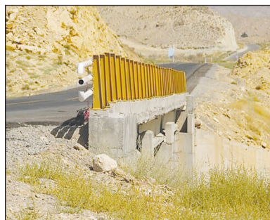
پروژه تاکنون ۲ هزار و ۵۰۰ متر مکعب بتن ریزی
